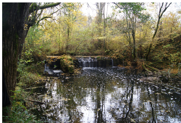
Vue générale du site de l'ouvrage et du lit aval
