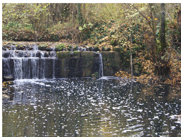
Vue agrandie, faisant apparaître les matériaux rocheux derrière les maçonneries
